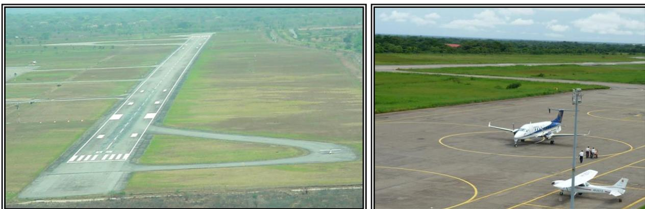
**PLATAFORMA:** Se cuenta con una plataforma de una de longitud aproximada de 338 metros lineales por 74 metros de ancho, para un área total de aproximadamente 25.012metros cuadrados, donde se está demarcado una calle de rodaje paralela a la pista y cinco posiciones a contacto para aeronaves categoría C, 2 helipunto y tanqueo de aeronaves, no se cuenta con señalización vial.
